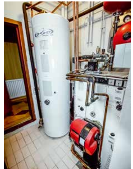
Varaajan alaosaan ohjataan aurinkokeräimien tuottama lämpö. Yläosaan virtaa takan tuottamaa lämpöä, joka hyödynnetään ensin ja vasta sitten otetaan öljylämpö käyttöön.
