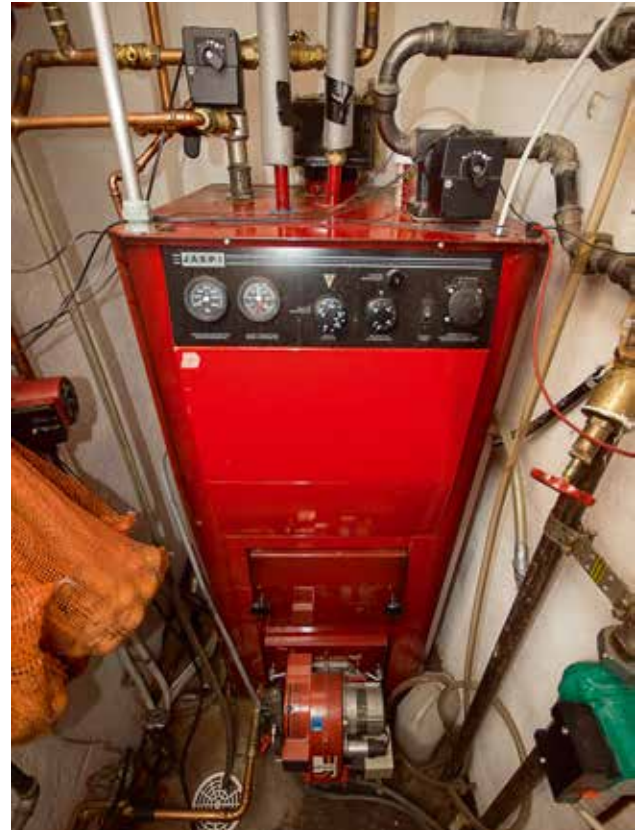
Jäspi Eco Lux 17 -öljykattilassa on pienestä koostaan huolimatta suuri vesitila.
