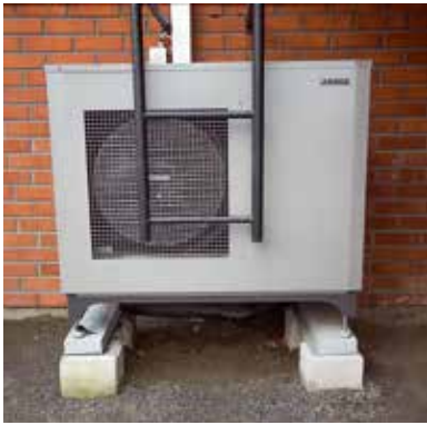
Ilma-vesilämpöpumppu JÄMÄ Moon 9 on vaimeäääninen. Sen alin käyttölämpötila on jopa 25 pakkasastetta.
