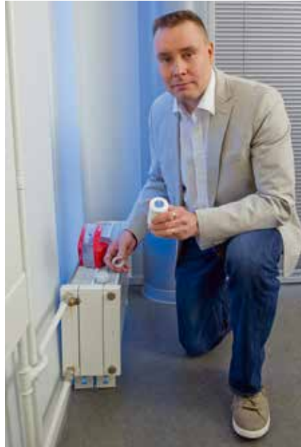
Termostaattikin väsy vanhetessaan, jolloin sen säätökyky ja tarkkuus heikkenevät, muistuttaa tekninen asiantuntija Jari Kivelä Danfossilta.
