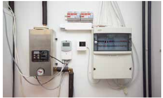
Ilma-vesilämpöpumppu JÄMÄ Moon 9 on vaimeäääninen. Sen alin käyttölämpötila on jopa 25 pakkasastetta.
