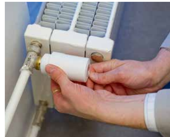
Danfossin älykäs patteritermostaatti reagoi ikkunan avaamiseen, ja kesäaikaan työttömän termostaatin kunnosta huolehtii jumbpa-toiminto.
