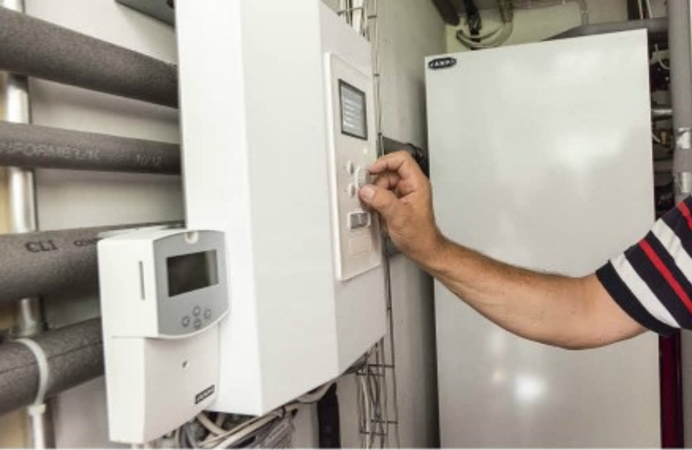
Jämä MCU 40 -ohjausjärjestelmä mahdollistaa sekä shunttiohjatun että porrashoitajun lisälämmön käytön.
