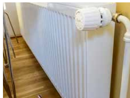
Vanhat patterit korvattiin matalalämpöpattereilla.
