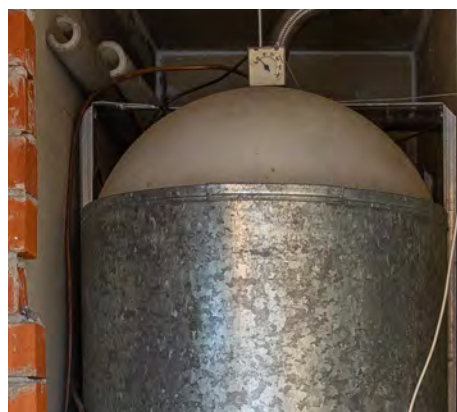
Uusittu kattila, huolella asennettu sisäsäiliö ja turvallinen purkupaikka ovat valmiina uuteen öljytoimitukseen.
