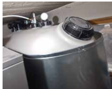
Öljysäiliö vaihdettiin, koska vanha säiliö oli 50 vuotta vanha. Motoralin 1 500 litran säiliö asennettiin vanhan säiliön paikalle. Tilaa vapautui lämpöpumpulle ja varaajalle.
