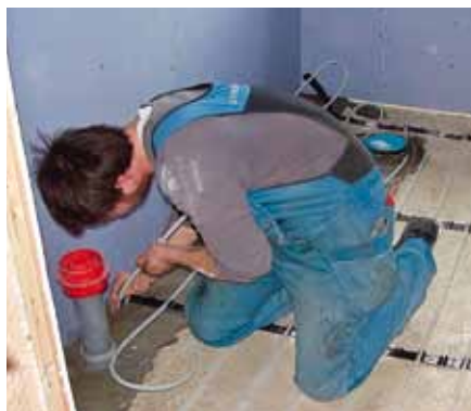
Sähköinen lattialämmitys korvattiin vesikiertoisella. Uponorin pienihalkaisijainen 12 mm:n lattialämmitysputki oli remonttiin sopiva ratkaisu, eikä nostanut lattiapintaa liikaa.
