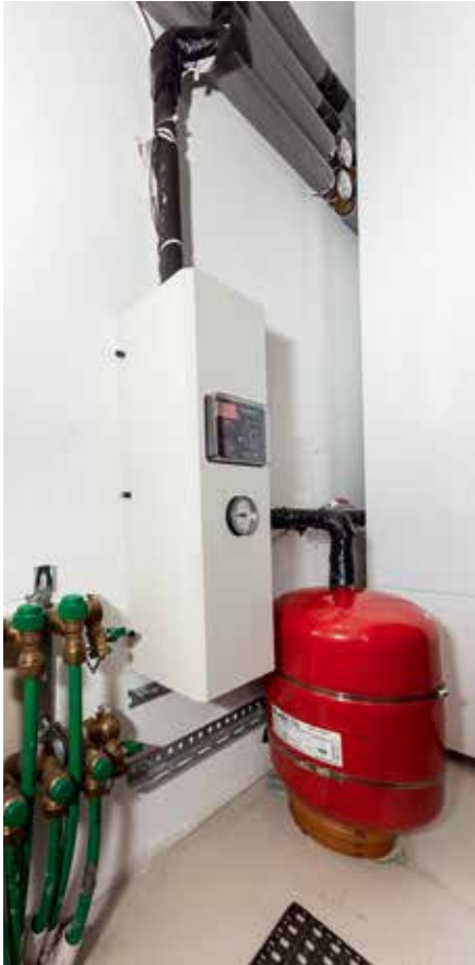
Aurinkolämpö on liitetty vesikiertoiseen lattialämmitysjärjestelmään, mikä edelleen nostaa järjestelmän tehokkuutta.
