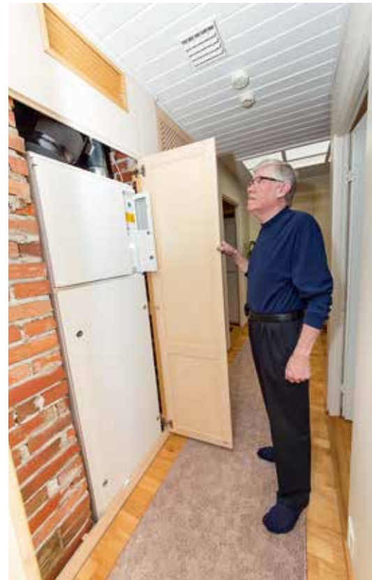
Enervent Kotilämpö -ilmanvaihtolaitteessa on lämmönsiirrin, joka saavuttaa yli 70 prosentin vuosihyötysuhteen.
