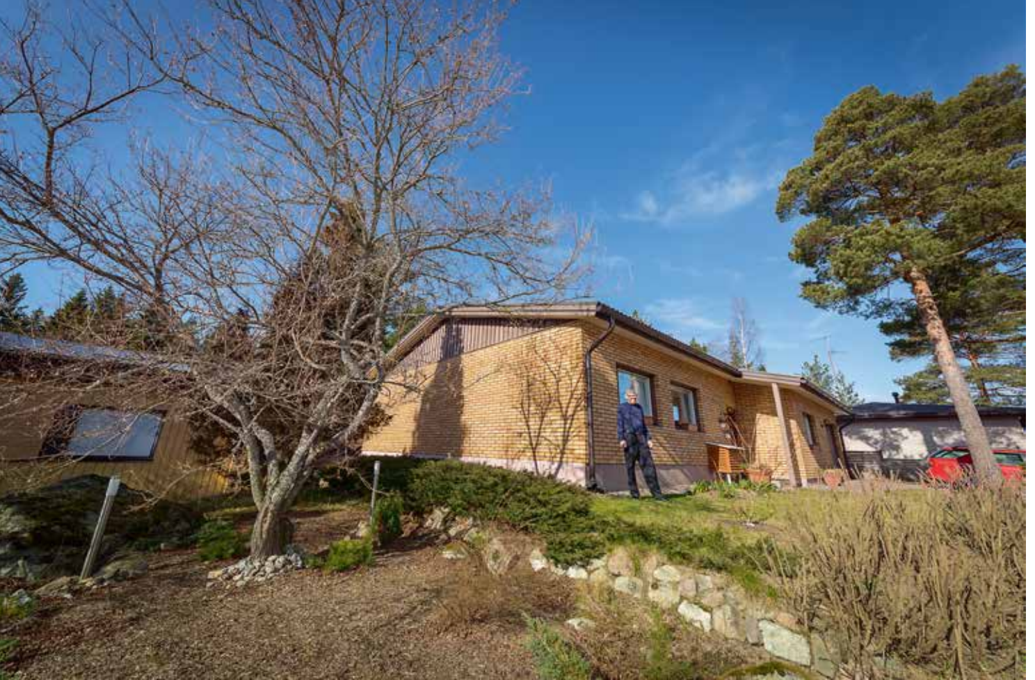
Virolaisten Porvoon koti sai harjakorkeuden vuonna 1980. Aurinkolämpöjärjestelmä tuottaa energiaa helmi-maaliskuusta pitkälle syksyyn.
