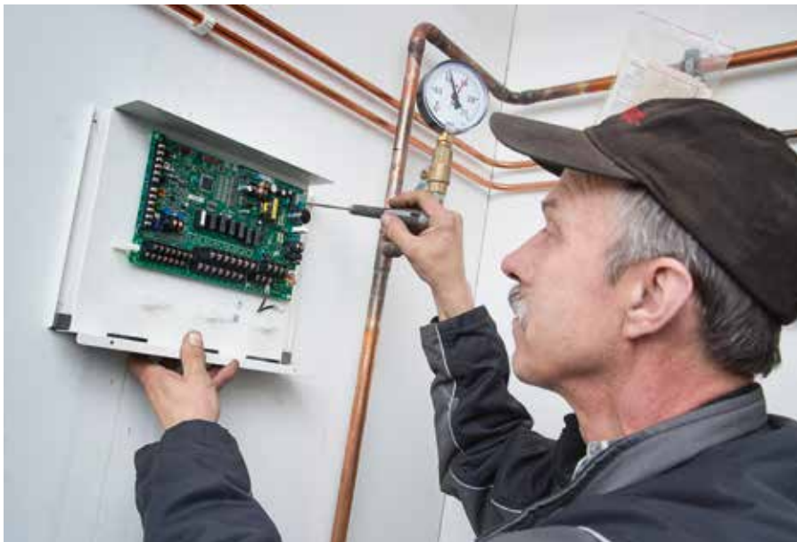
Lämpöpumpun säätökeskus sijoitetaan teknisen tilan seinälle.
