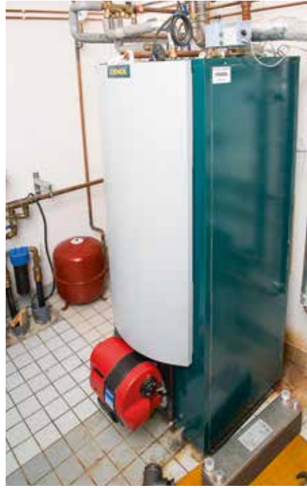
Jämä-kattila ja Oilon-poltin löytyvät Haapasen perheen pannuhuoneesta.
