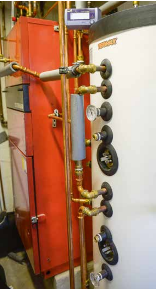
Termaxin 4-tieventtiili on lämmitysjärjestelmän sydän ja Oumanin automaatiikka sen aivot.
