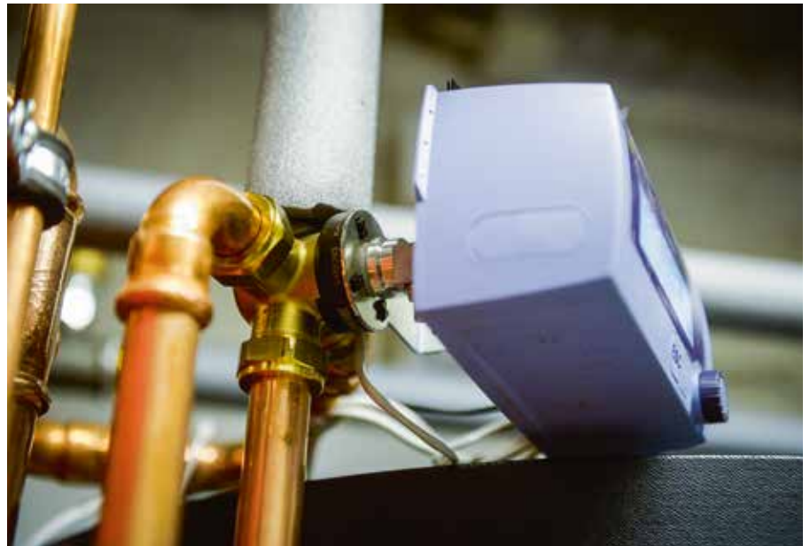
Termaxin 4-tieventtiili on lämmitysjärjestelmän sydän ja Oumanin automaatiikka sen aivot.
