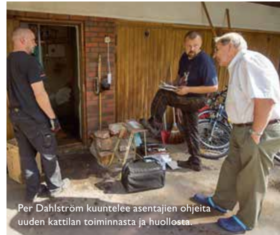
Vanhan kattilan purku ja uuden asennus sujuivat ammattilaisilta nopeasti.
