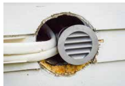
Pannuhuoneen ilmanottoaukkoa pienennettiin.
